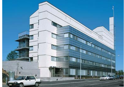
Die weiße Keramikverkleidung des Zentralflügels vermittelt Leichtigkeit und steht in reizvollem Kontrast zur Edelstahlfassade.
