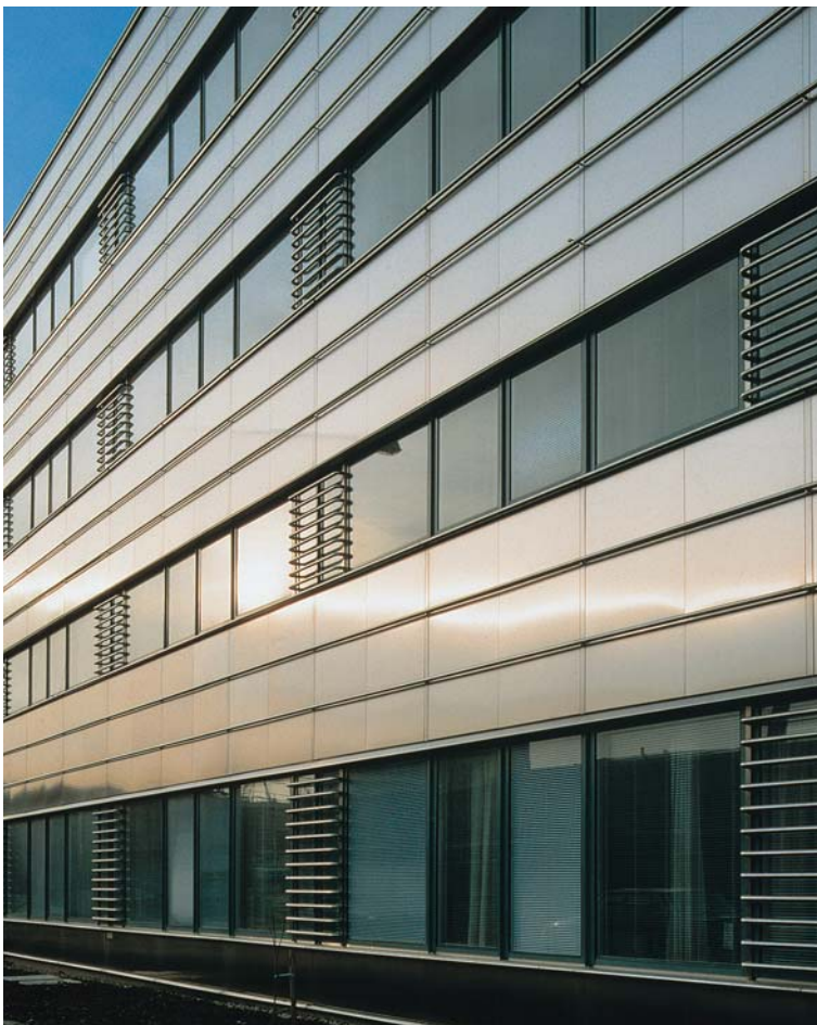
Edelstahl Rostfrei-Rohre vor den Kassetten bilden eine zweite Ebene und gliedern die Fassade.
